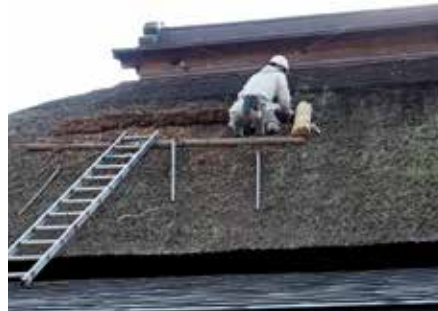
茅葺屋根の補修
